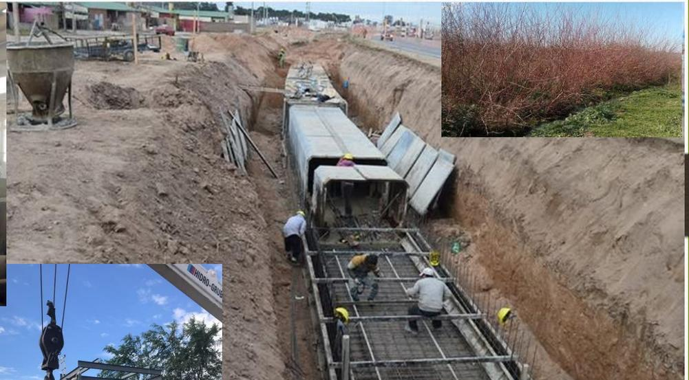
**OBRA DE CANAL PLUVIAL Y PROFUNDIZACIÓN DE CUENCOS**
